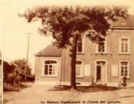
La Maison Communale et l'école des garçons.
