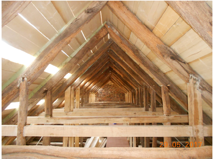
Vue intérieure de la charpente romane (en 2017 durant les travaux). © Bureau d'études de la Ville de Namur
