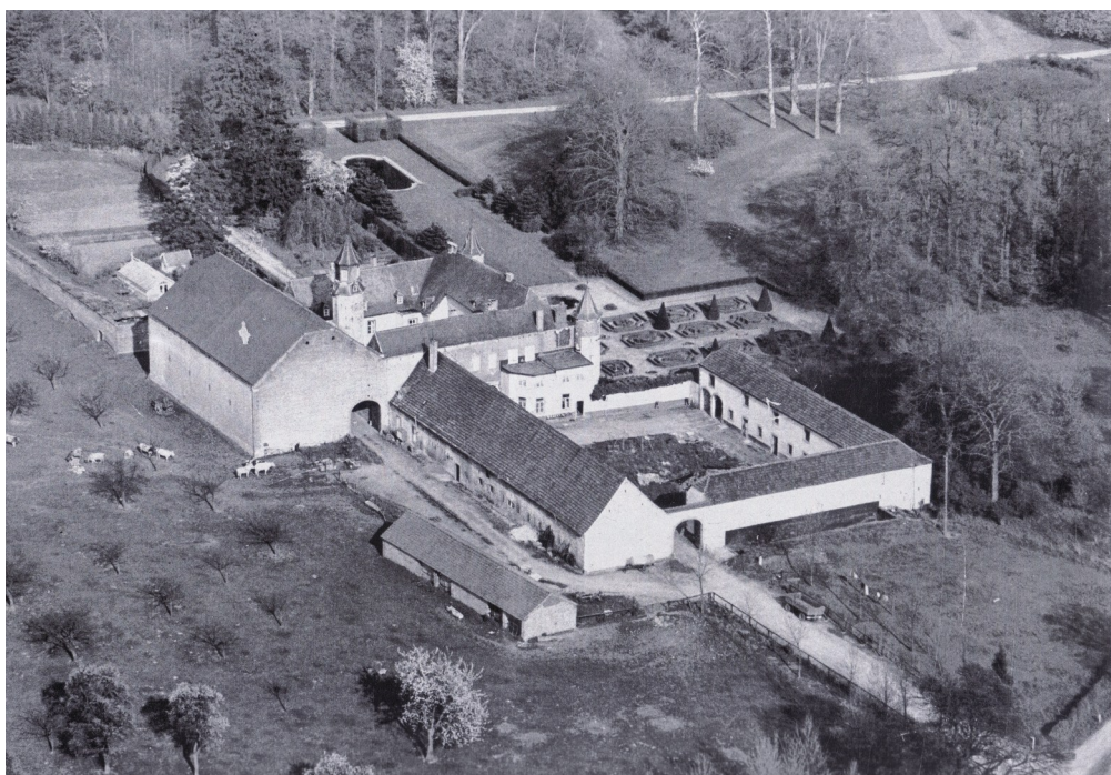
Vue aérienne de la ferme (non datée)
