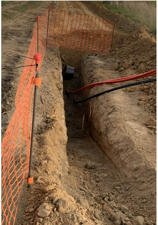
Tranchée de 1,2 mètre de profondeur pour la pose des câbles
