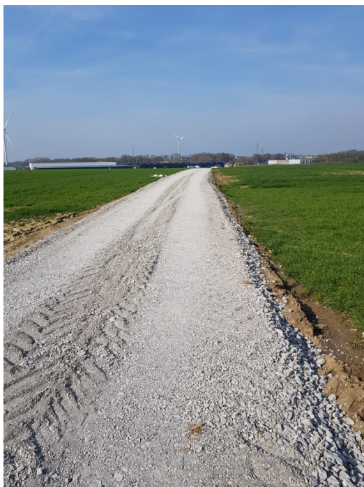
Fondation de la voirie vers la future éolienne
